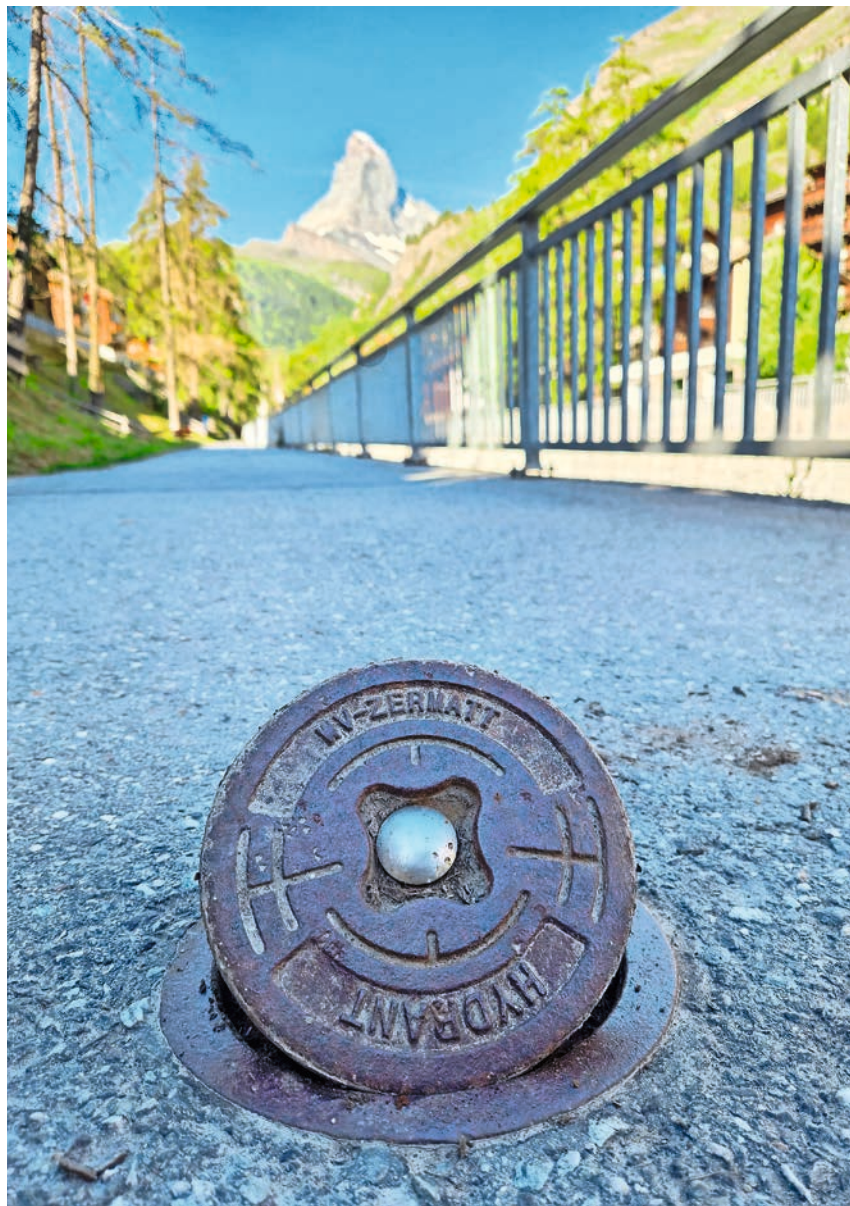
Thermobeschichtete Strassenkappen werden in Zermatt seit über zehn Jahren erfolgreich eingesetzt.
